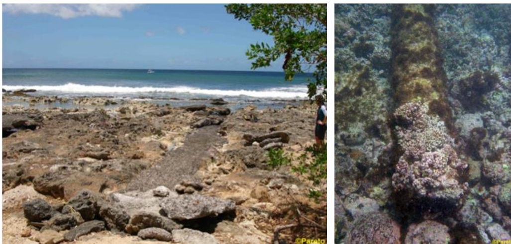
Figure 24 – Rejet de la STEU intégré dans la dalle corallienne et fin de l'émissaire dans un petit fond sur récif corallien (photo de 2010 ©Pareto)
