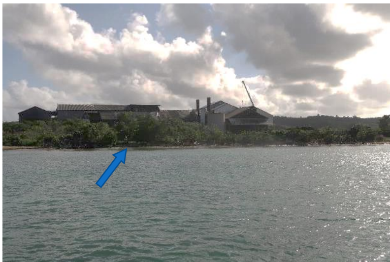
Figure 149 - Vue de l'usine SRMG (la flèche indique la zone de rejet supposé)
