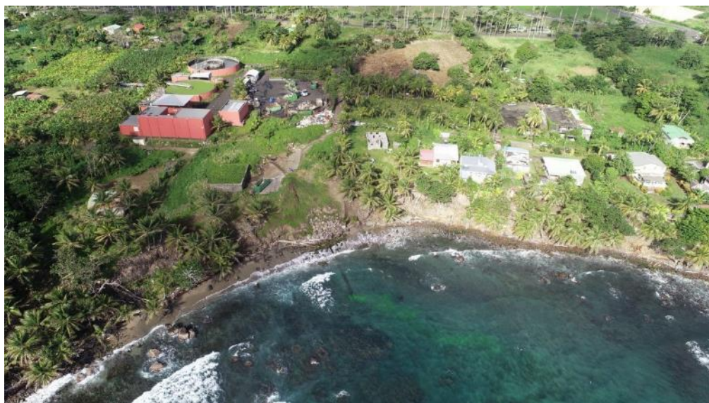
Figure 64 - Photo aérienne de l'émissaire de la STEU de Capesterre B.-E. (source : DEAL)
